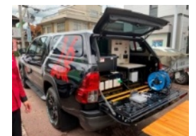
搭載する発電機・電源コンセント
