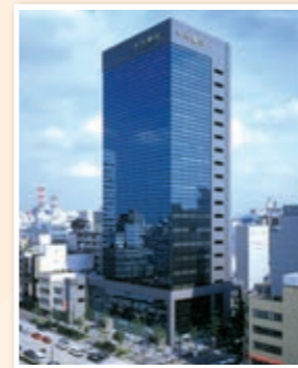
名古屋ビル(名古屋市)
