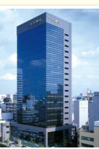
名古屋ビル(名古屋市)
