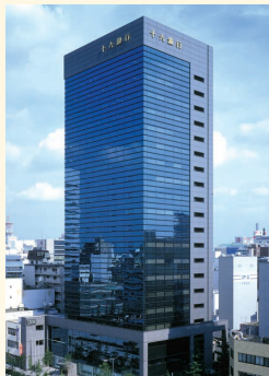
名古屋ビル(名古屋市)
