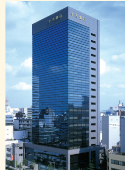
名古屋ビル(名古屋市)
